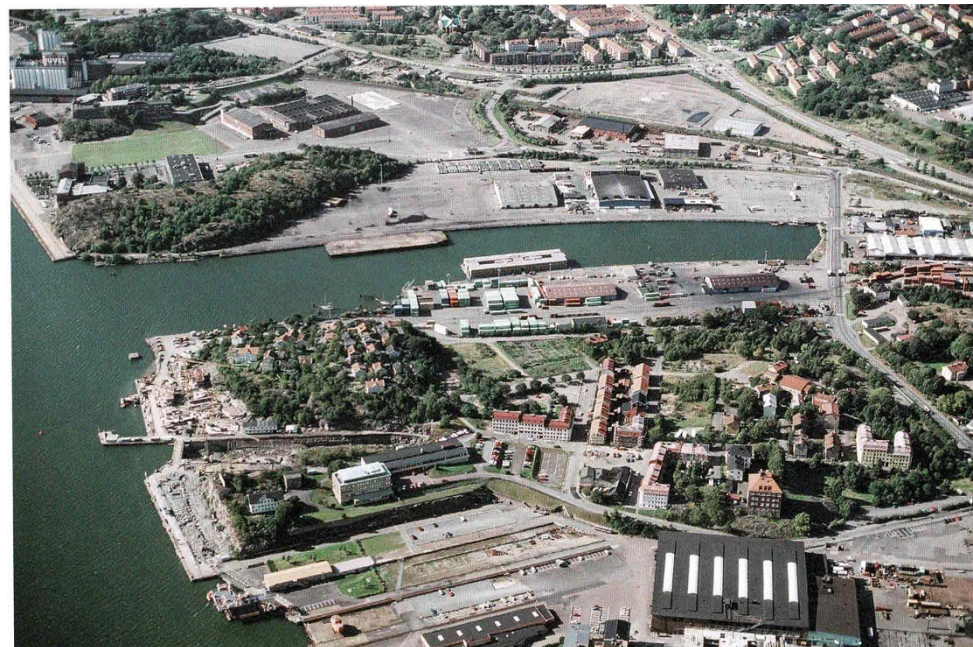
Lindholmen med Slottsberget, Sannegårdshamnen och Sörhallsberget 1990. På stranden nedanför Slottsberget pågår bygge. Källa: Lönnroth, 2019
